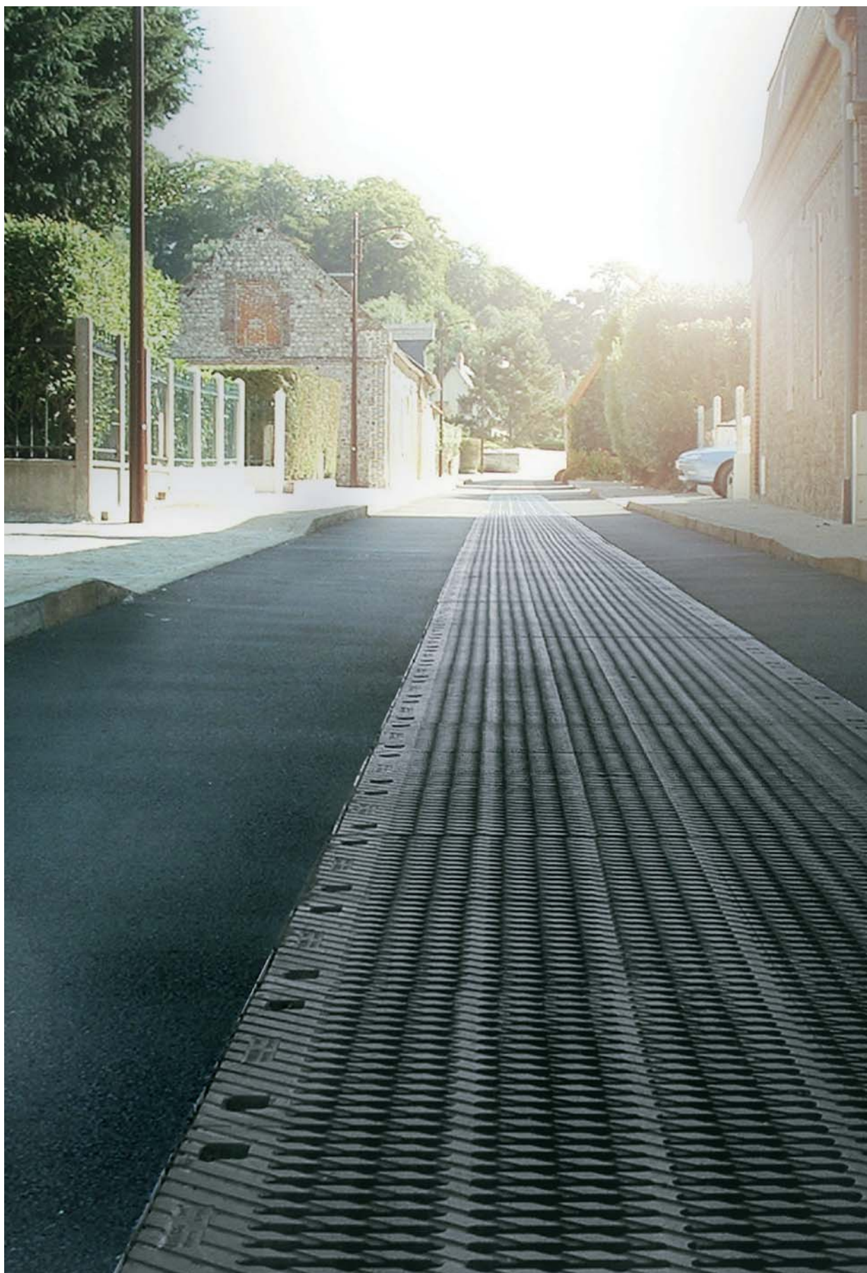
BIRCOsir DN 1000 à Saint Valéry en Caux, Normandie – protection contre les inondations.
