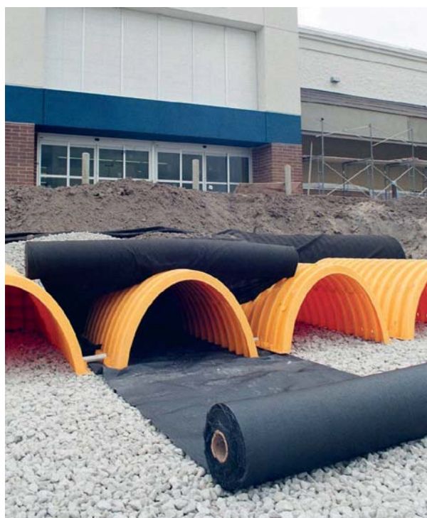
Image 11 : Géotextile tissé en bande double sous l'Isolator Row et enrobage au géotextile non-tissé pour les modèles SC-160, SC-310 et SC-740
