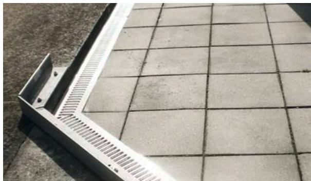
A Niort dans les Deux Sèvres, 220 mètres de caniveaux BIRCOsir DN 200 AS recouverts de caillebotis en fonte galvanisée ont été posés dans la rue piétonne desservant la place de la Brèche. Cette galvanisation constitue la meilleure protection anticorrosion possible sur une fonte ductile et valorise les pavés en granit.
