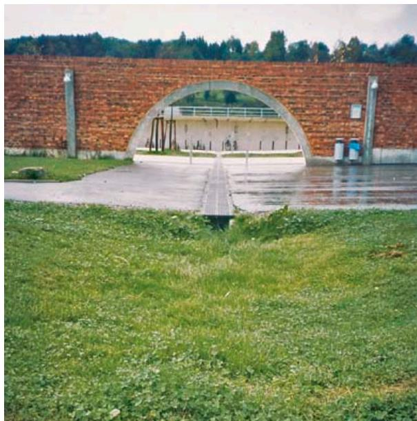
Transport des eaux pluviales jusqu'à la prochaine possibilité d'infiltration
