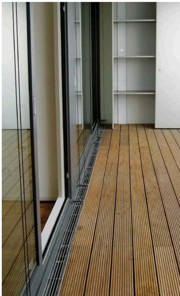
Transitions accessibles pour les handicapés, de la terrasse à l'appartement. Réalisé avec BIRCOtop et recouvrements en aluminium de BIRCO.
