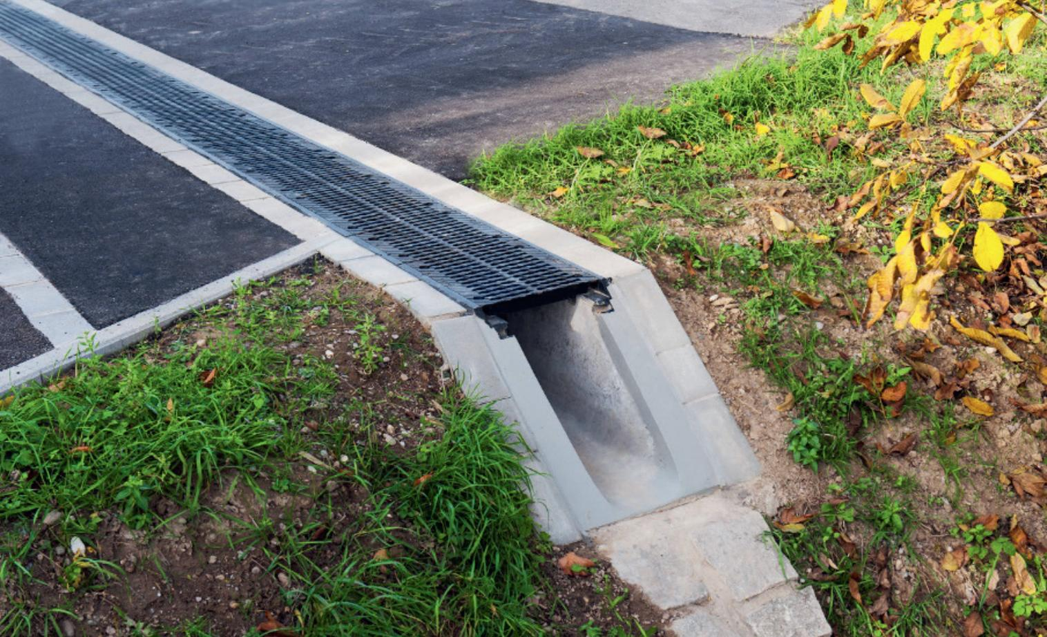
Le caniveau BIRCOmax-i qui effectue un drainage immédiat en cas de fortes pluies, assure la sédimentation et la filtration de substances nocives provenant des surfaces de circulation et garantit une haute sécurité routière.
