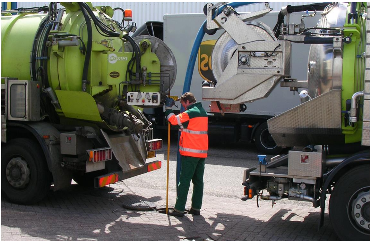
Les sédiments seront aspirés à partir du regard d'entrée
