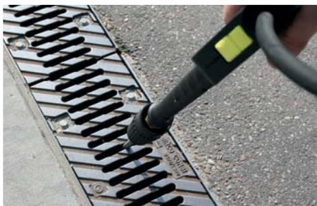
Pour être opérant, le système de drainage doit être nettoyé régulièrement à l'aide d'un appareil à haute pression.
