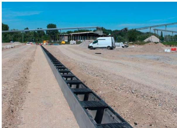
Stabilité et pérennité. La forme de construction du BIRCOmax-i, destinée à répartir les charges de manière optimale, a été développée spécifiquement pour supporter les charges des domaines d'exploitation les plus sollicités. La cornière en fonte fermement ancrée dans le béton, protège les surfaces de contact du caniveau. Une garantie de pérennité à long terme.
