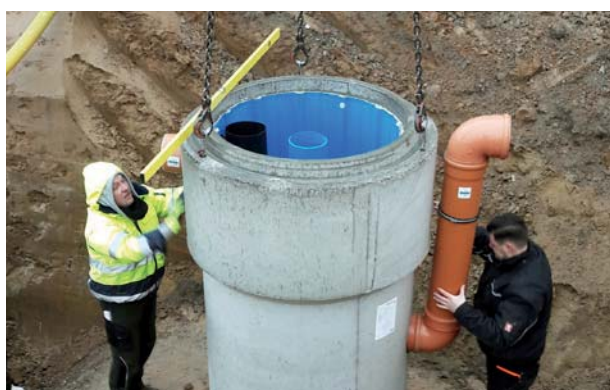
Projet de construction Stahndorf, Allemagne. BIRCOhydropoint® 1000. Installation simple et installation double. Raccordement à un dispositif de rétention.
