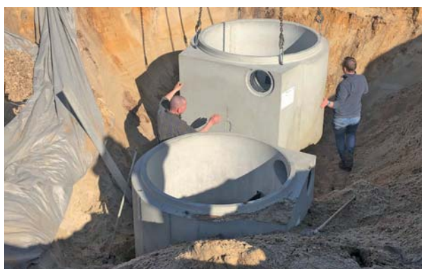
Projet de construction Wedemark, Allemagne. BIRCOhydropoint® 1500. Installation double avec raccordement à un dispositif d'infiltration décentralisé.
