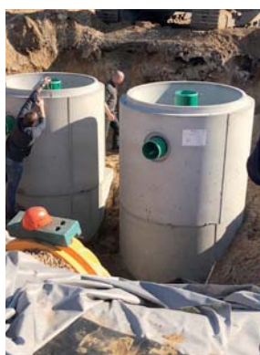
Projet de construction Wedemark, Allemagne. BIRCOhydropoint® 1500. Installation double avec raccordement à un dispositif d'infiltration décentralisé.
