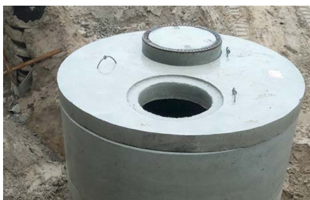
Projet de construction Stahndorf, Allemagne. BIRCOhydropoint® 1000. Installation simple et installation double. Raccordement à un dispositif de rétention.
