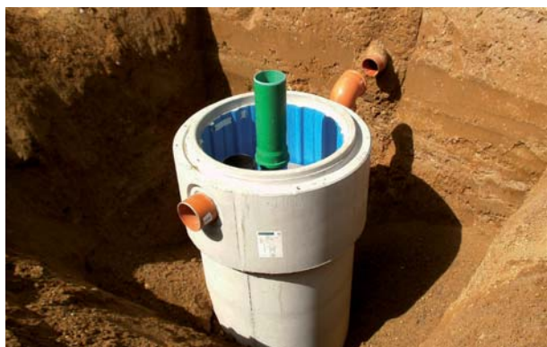
Projet de construction Bietigheim, Allemagne. Installation dans un regard en béton DN 1000 avec raccordement à un dispositif de rétention.
